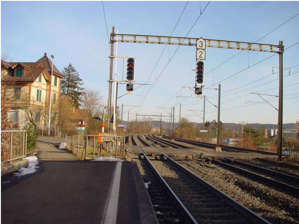
Dietlikon mit den Ausfahrsignalen D1 und D2. Dahinter ist der mit Barrieren gesicherte Bahnübergang erkennbar.
