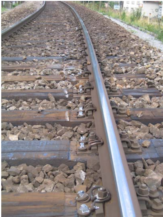
Erste Entgleisungsspuren nach links (in Fahrrichtung gesehen)
